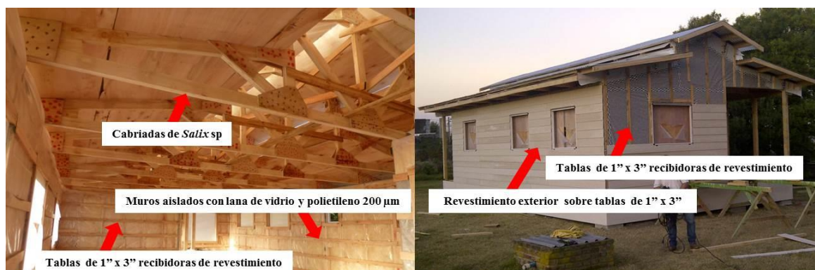
Figura 2. Detalle de cabriadas y muros interiores.
